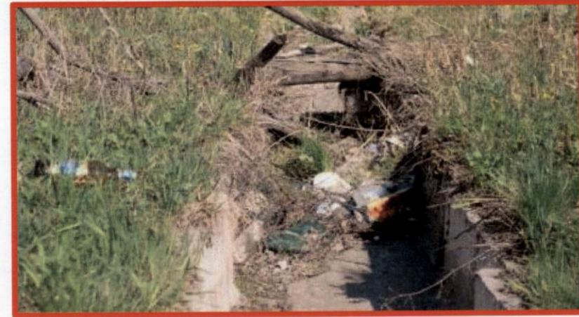
**Не очищенная от мусора система водоотвода (водоотводные, прикромочные лотки, быстротоки, нагорные канавы и т.д.)**
